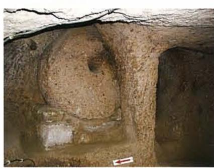
写真3. 上の地下都市内の通路で、円盤状の板は危機の際に横に転がして通行を遮断する。
